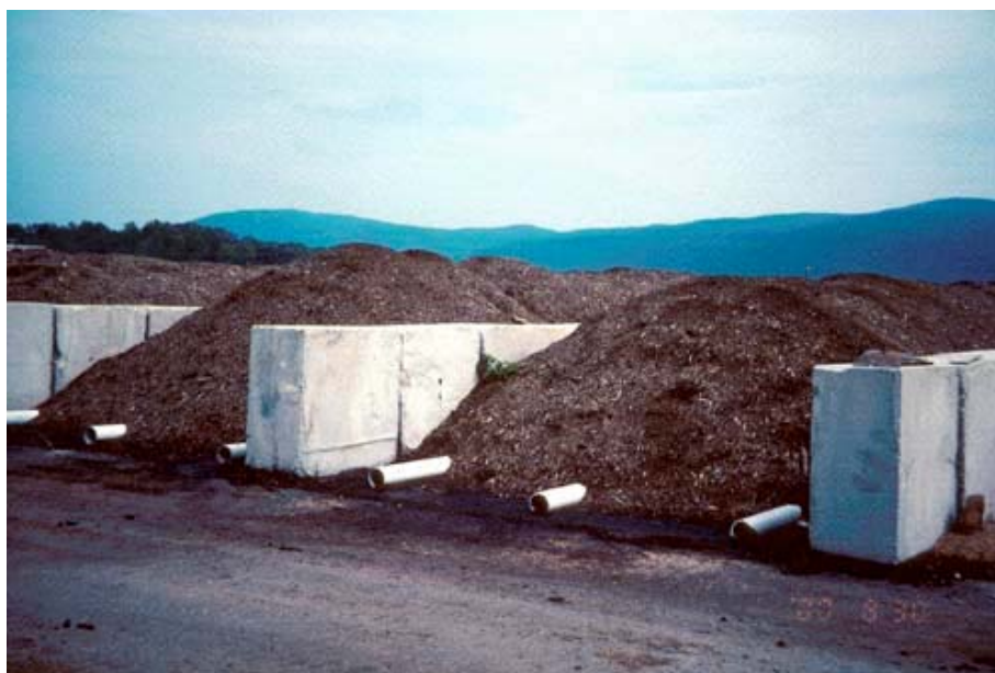
Figur 19. Anlegg med statisk rankekompostering. Luft tilføres gjennom parallelle perforerte rør i basen av kompostmassen.
