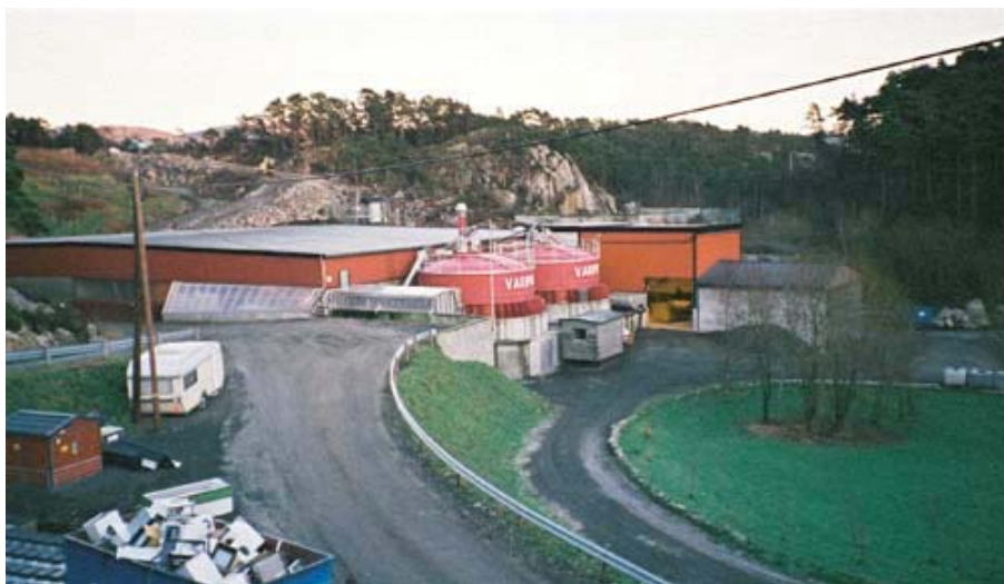
Figur 13: Anlegget på Erikstemmen er eksempel på en fullstendig lukket komposteringsprosess.
