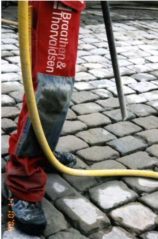
4. Høytrykksblåsing sørget for at all løs masse kunne samles opp og fjernes.
