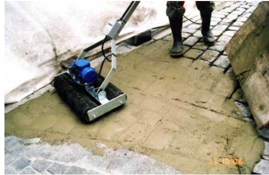
6. Fugemassen ble "komprimert" med lett vibratorplate for å være sikker på god pakking og fylling av fugene.
