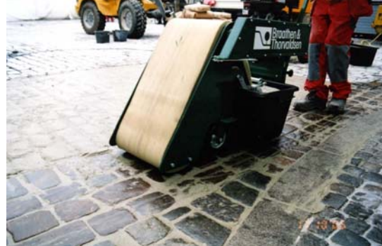
7. For å rengjøre brosteinoverflaten ble det benyttet "vaskemaskin" som er konstruert for slike formål. Det aller meste av overflødig fugemasse ble fjernet på denne måten. De få restene som ble igjen, vil forsvinne etter noen tids slitasje.
