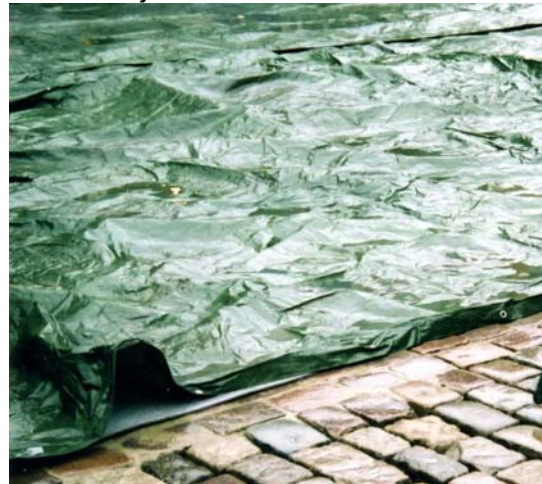
8. For å ivareta og fremme herdeprosessen er det viktig at belegg/fuger blir dekket med plast og holdes fuktig i min. 7 døgn for å hindre uttørking av betongfugene.
