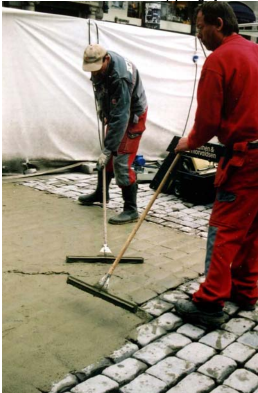
5. Ny betongmasse ble fremstilt ved å blande industrisement og to ulike typer finsand til grøtaktig konsistens som ble påført i fugene/belegget.
