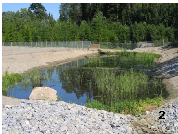
Eksempel på rensedam langs E6 i Råde ved Karlshus som medførte terrenngrep og fjerning av vegetasjon. Sedimentasjonsbassenget er en del av flere bassenger som ble bygget som ledd i et FoU-prosjekt (Forsknings- og utviklingsprosjekt).
