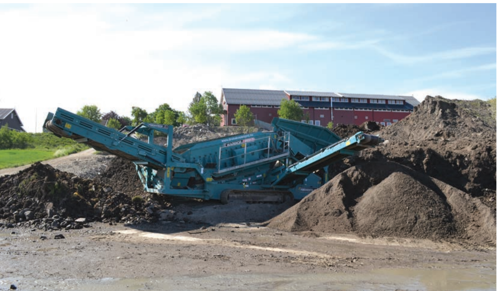
Figur 1. Sortering av gravemasser i jordproduksjonsanlegg. Foto: Trond Knapp Haraldsen
