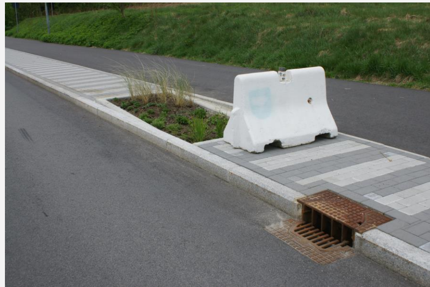
Type 321 – Innløp via sandfang
