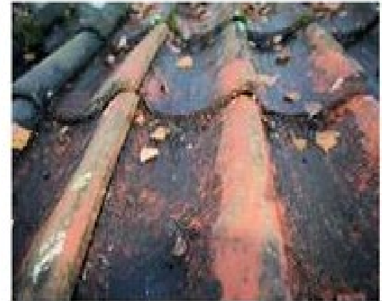
Figur 14 Uglassert takstein av tegl (alle fotos: Eirik Wærner)
