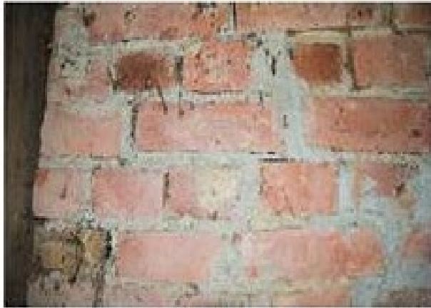
Figur 12 Gammel teglstein murt med kalkmørtel.
