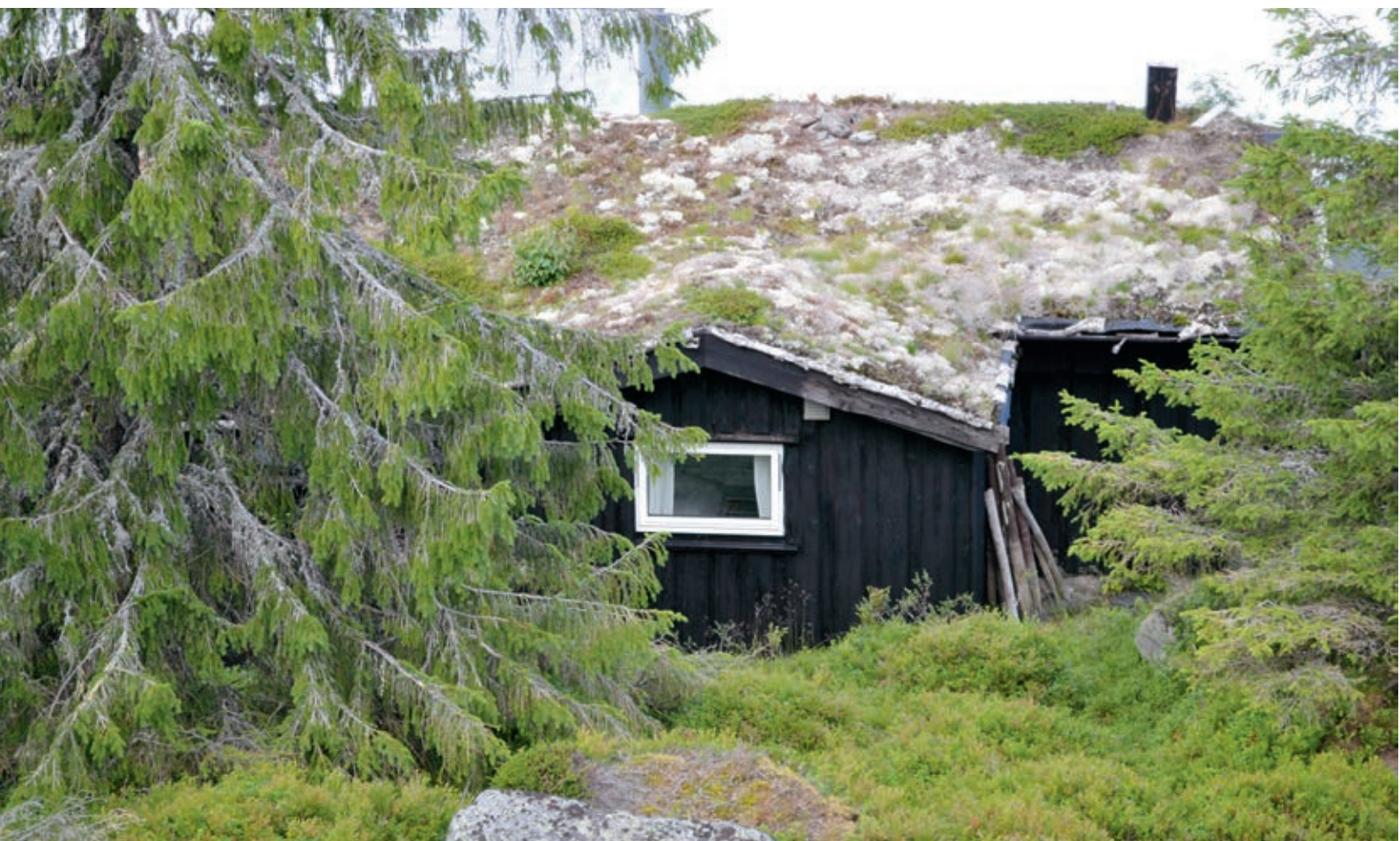
Foto 1. Tradisjonelt torvtak med undertak av never og vegetasjon av lav, moser og lyng som passer med omgivelsene.
