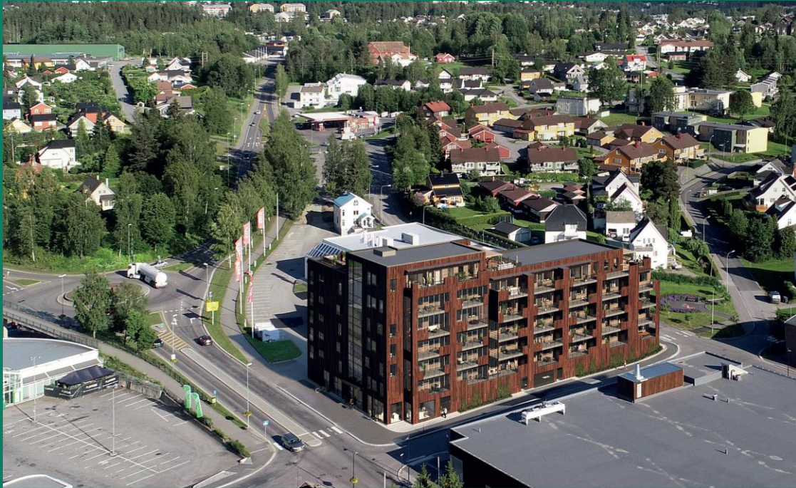
Under oppføring: Glommengata 3
