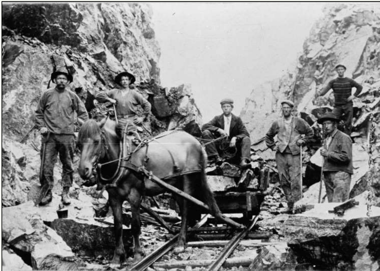
Bygging av Bergensbanen
