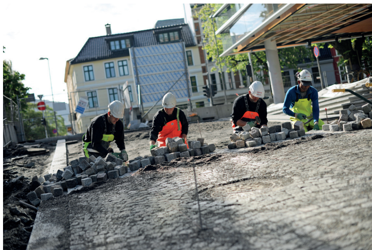
Fig. 10: Dekket fuges etterhvert og legges med litt overhøyde før avsluttene komprimering av belegget.
