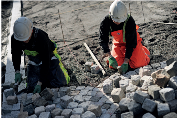
Fig. 8: Arbeid utføres på utsiden av buen og stein lagres på allerede lagt stein. Snor går gjennom hjertesteinen.
