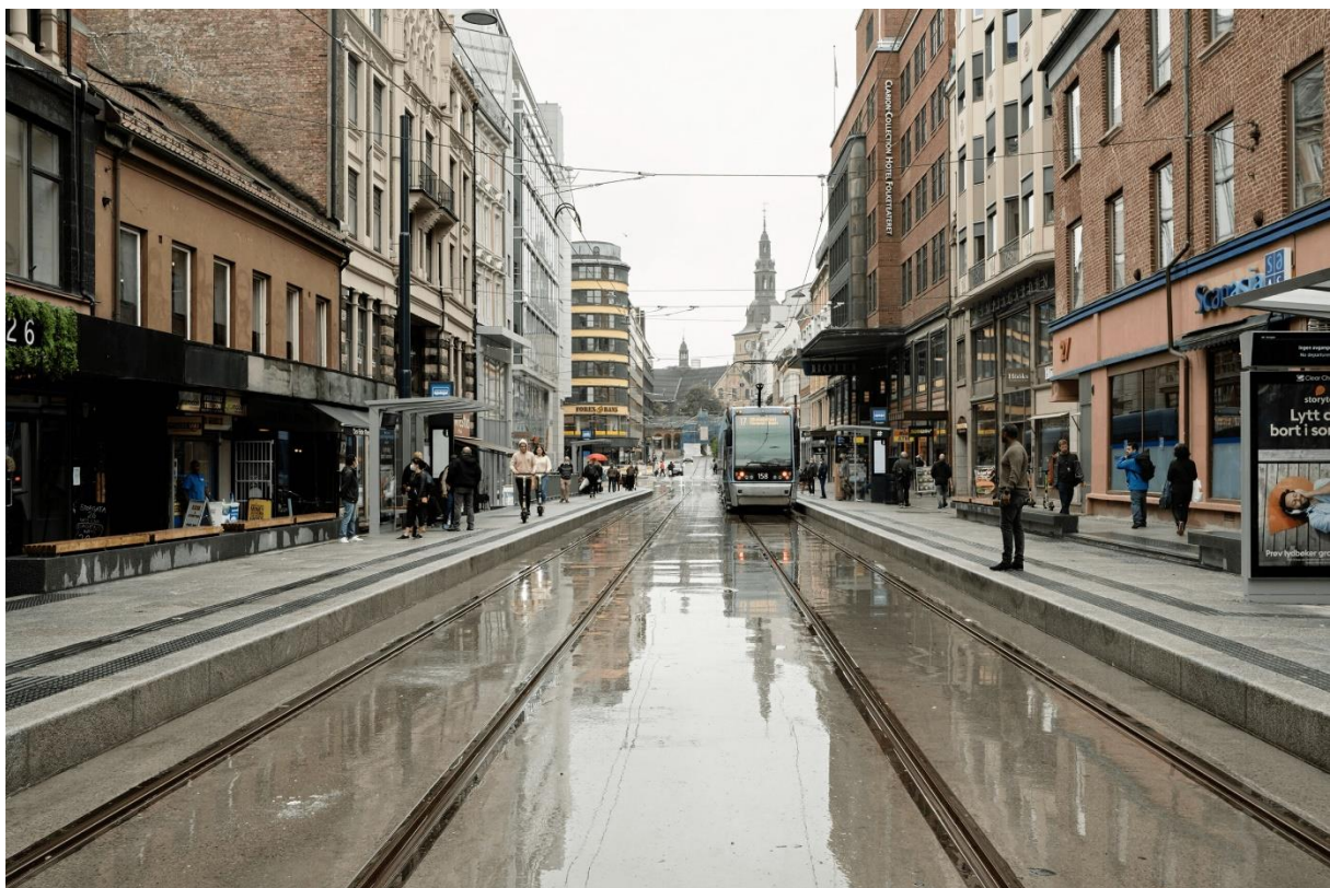
Figur 22 Storgata, etter at tiltaket er gjennomført. Foto er lånt fra SWECO.
